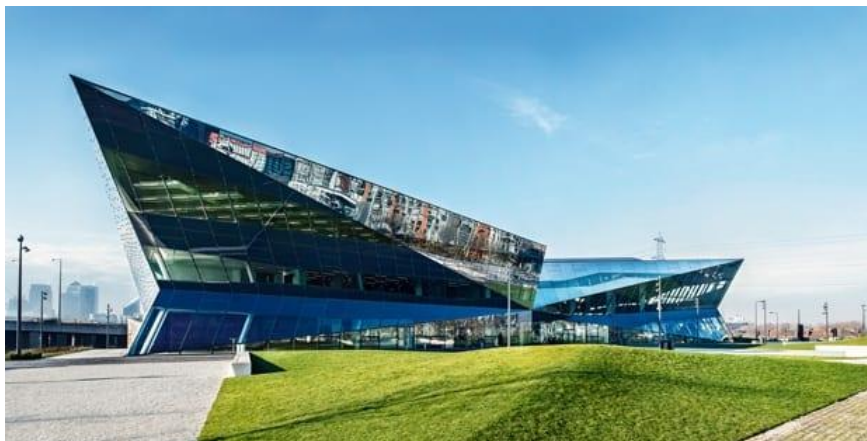
Slika 1. The Crystal, London – krov izrađen od 100% recikliranog aluminija [4]
